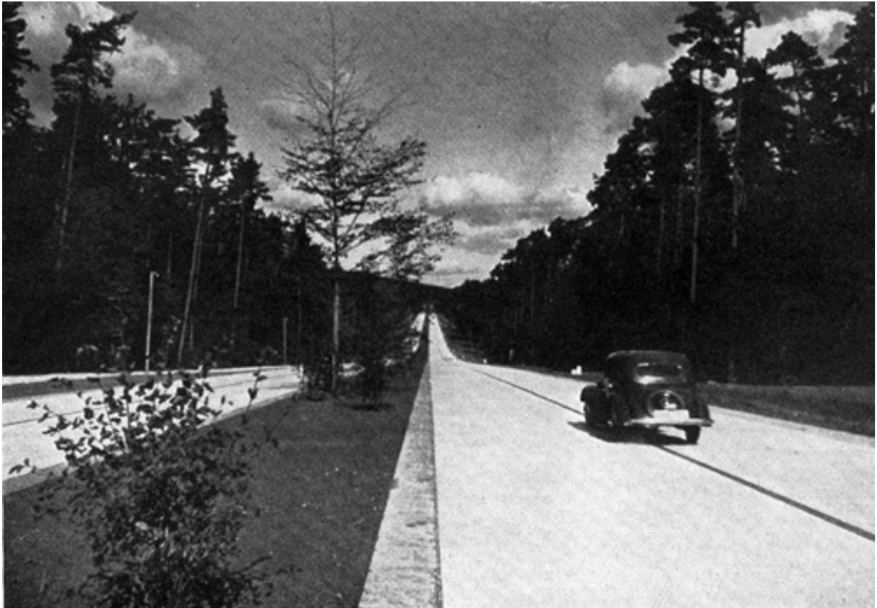
Durchschwingen einer längeren Geraden im flachen Gelände / Im Grundriss eine gerade Strecke, im Raumbild dreiteilig, nämlich zwei gerade Strecken mit Ausrundungsbogen im Neigungswechsel
